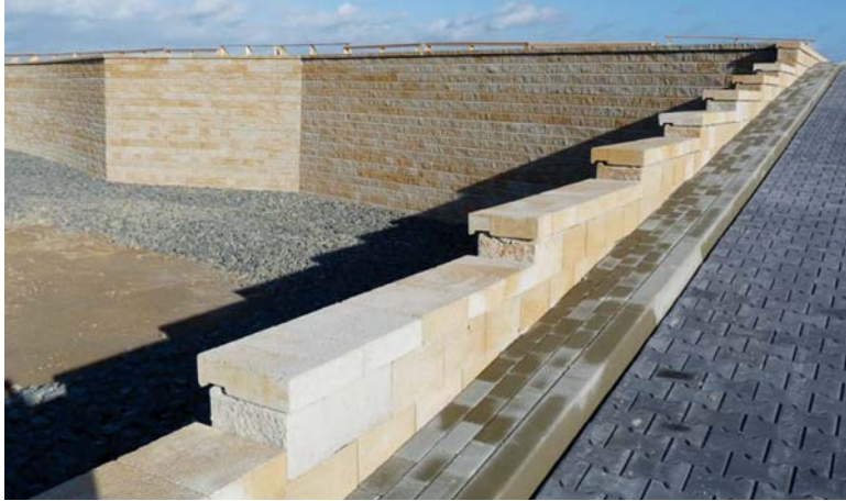
Figuur 3 – Blokkenwand Kademuurconstructie bij oplevering.
