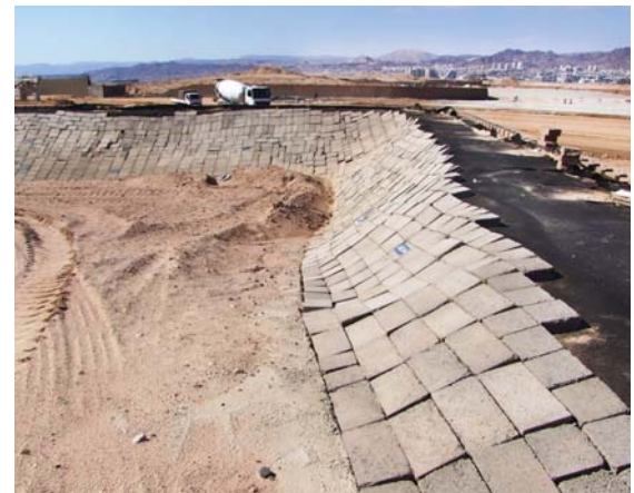
Figuur 11 – Afdichting en afdekking van het geomembraan achter het gewapend grondmassief.
