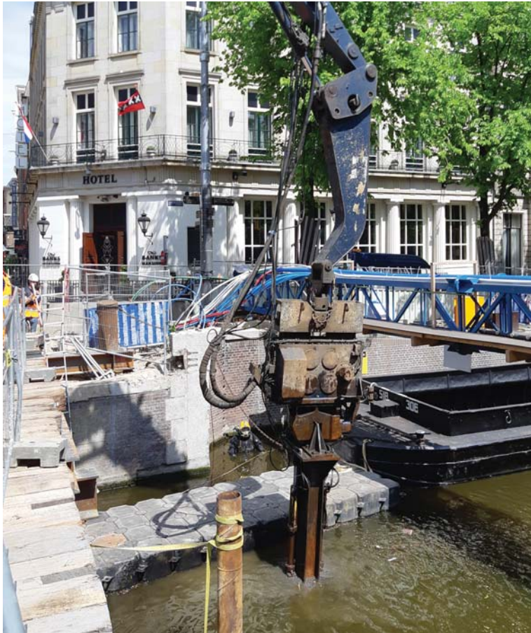
Foto 2 en 3 – Uitvoering van de klem-methode bij brug 30 en 41 in de Vijzelstraat. Bron - Gemeente Amsterdam.
