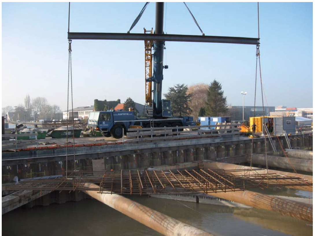
Figuur 5 Plaatsen wapening.
