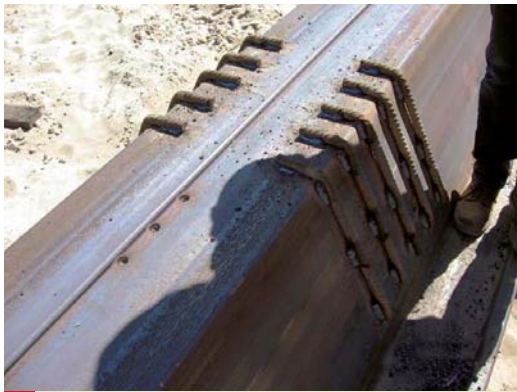
Figuur 4 Ribbels op damwand.
