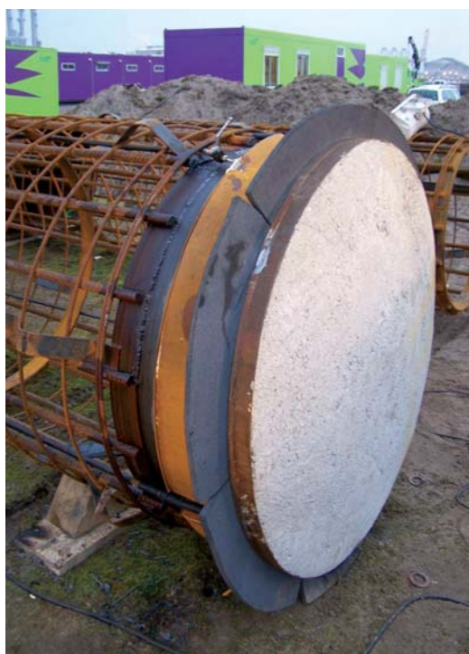
Figuur 5 Gecombineerde lift- en drukcell onderaan de paalwapening.
