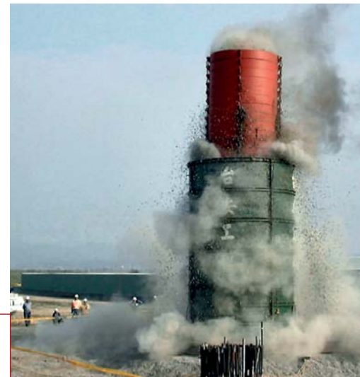
Figuur 10 Uitvoering van een 20 MN statnamische proefbelasting
