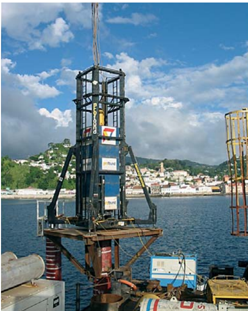
Figuur 7 Het uitvoeren van een statnamische proefbelasting met een 4 MN apparaat met een hydraulisch vangmechanisme
