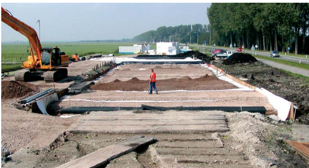
Figuur 5 Overzicht van de aanleg van het meetvak
