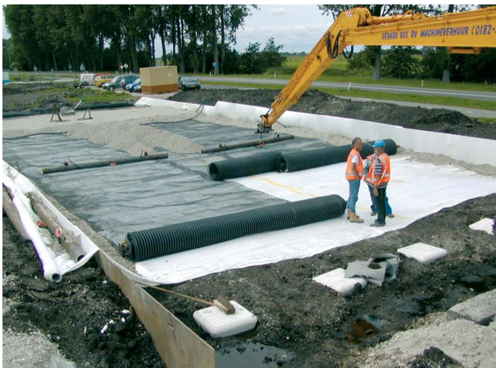
Figuur 4 Plaatsen van de onderste laag Fortrac plus Stabilenka
