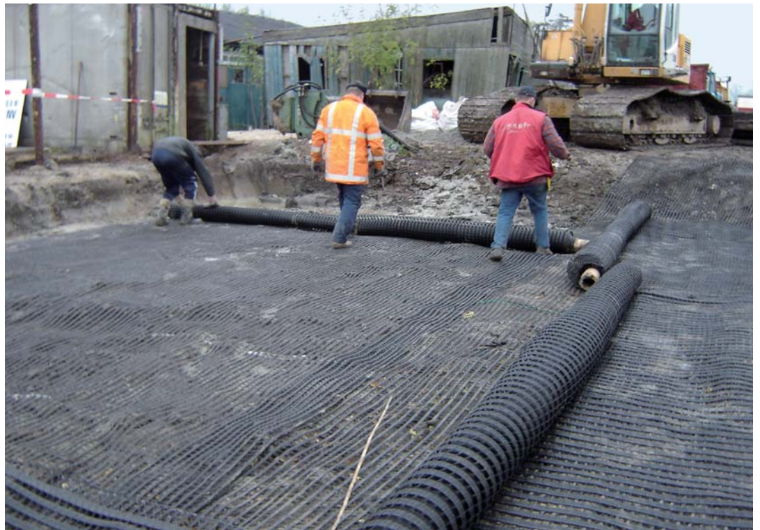
Foto 2 Aanbrengen geogrids voor de Kyotoweg.
