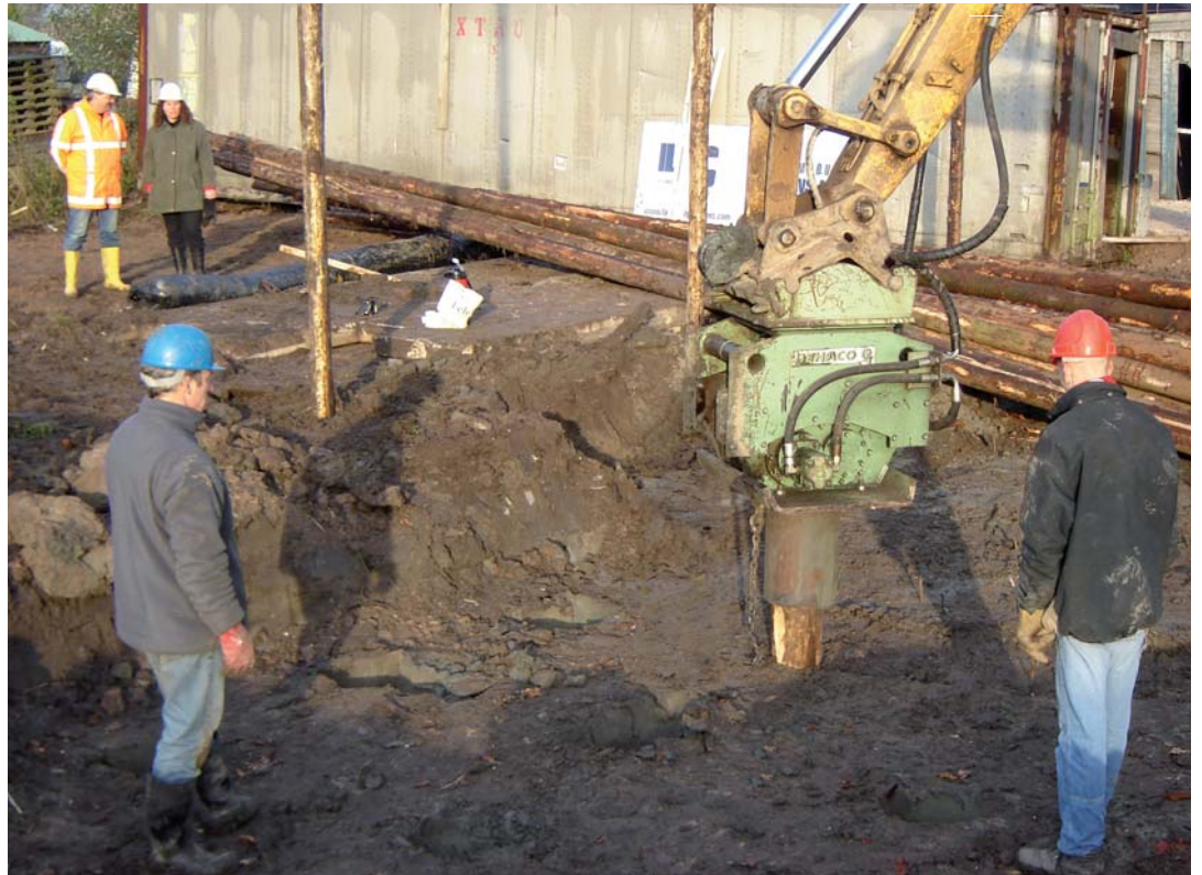
Foto 1 Aanbrengen houten palen voor de Kyotoweg.
