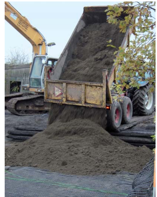
Foto 3 Het storten van het baggerspeciemengsel op de geogrids.
