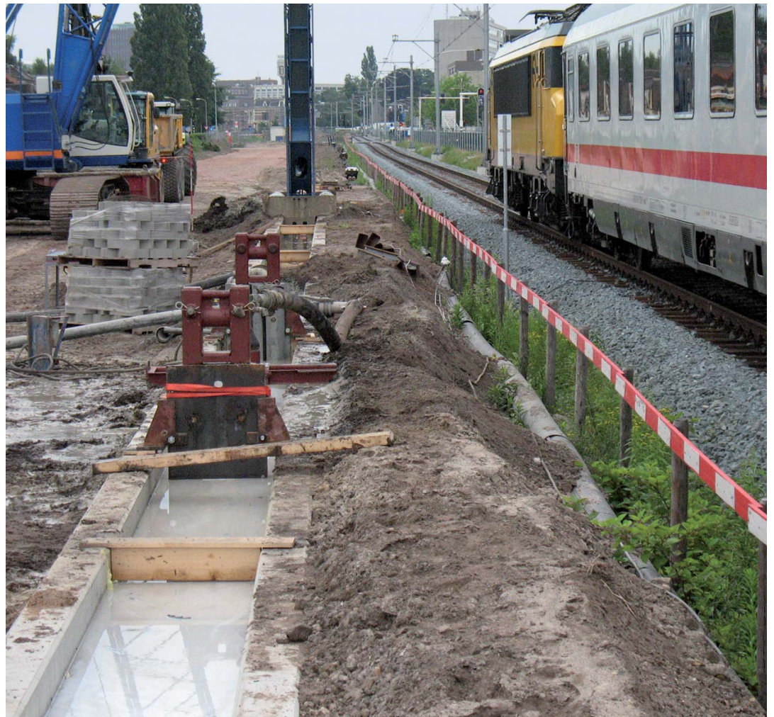
Figuur 10 Werk in uitvoering (foto Volker Staal en Funderingen).
