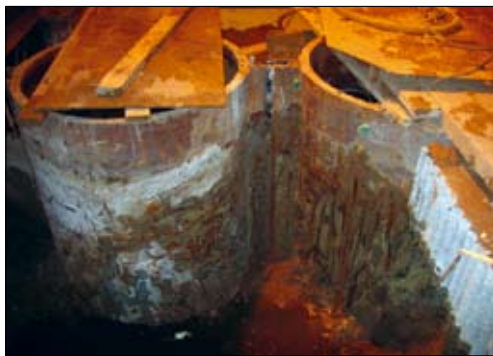
↑ Figuur 14 Een MT wand in wording: deels vrijgegraven MT palen
