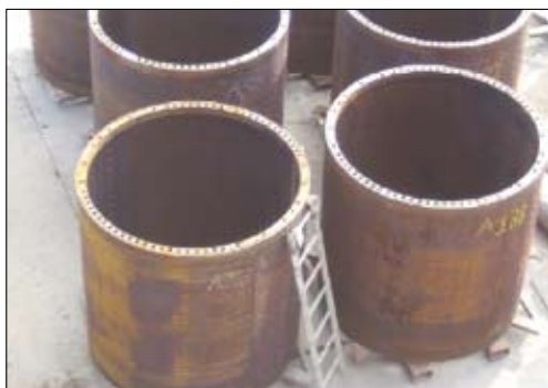
↑ Figuur 4 De palen worden opgebouwd uit stalen segmenten \varnothing 1.820 mm en 1.850 mm hoog
