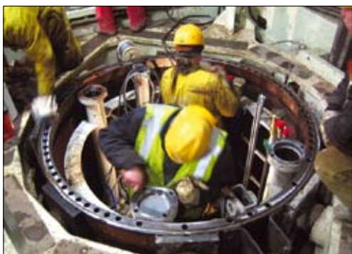
↑ Figuur 5 Voorbereidende werkzaamheden voor het koppelen van de stalen segmenten door middel van boutverbindingen
