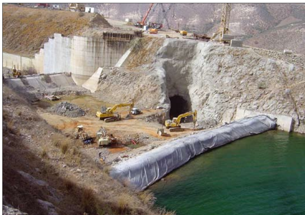
↑ Foto 3 Installatie Geotube®systeem, stuwmeer Marokko
