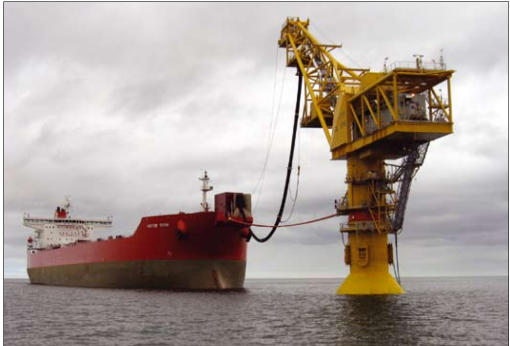
↑ Figuur 3 Een 110.000 DWT tanker afgemeerd aan de geïnstalleerde SPM-toren. De tanker wordt geladen door een laadslang die aan de boeg is gekoppeld.
