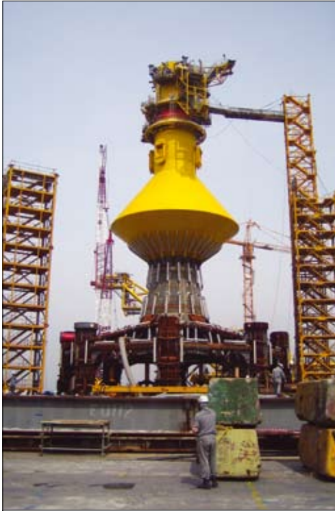
↑ Figuur 6 De toren tijdens de constructie, met in het midden de ice cone. De toren staat op acht zogenaamde pile sleeves die uiteindelijk worden verbonden met de funderingspalen.
