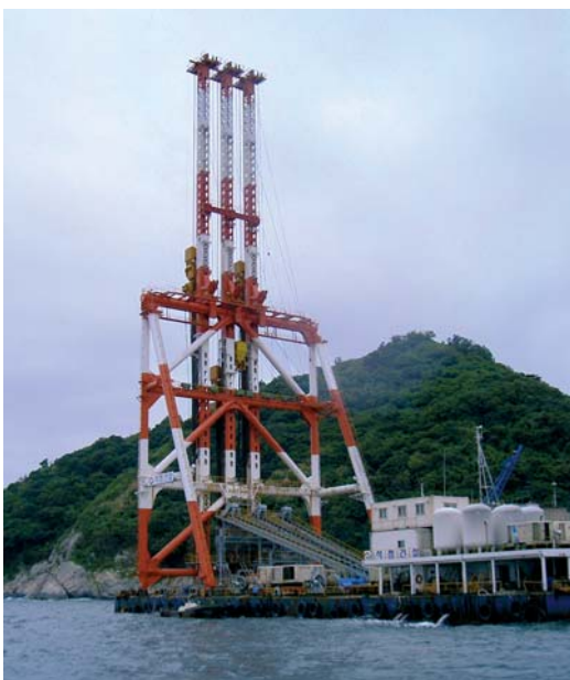
Grondverbetering SCP-procédé westzijde tunnel.
