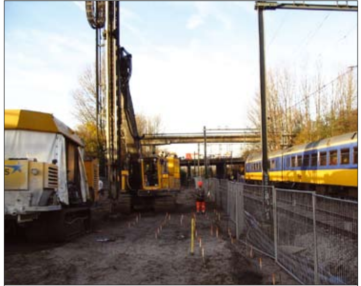
↑ Figuur 3 Uitvoering van MIP kolommen voor RandstadRail te Rotterdam
