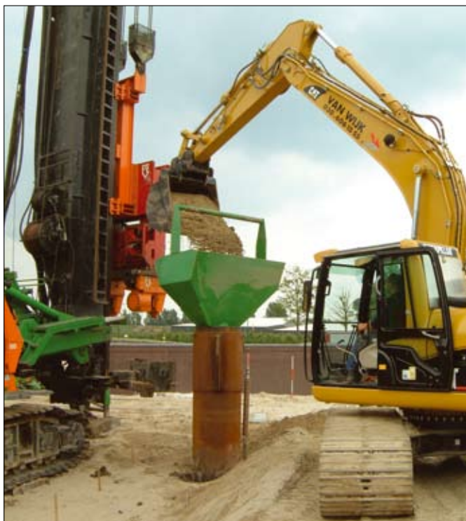
↑ Figuur 5 Principe / foto uitvoering van een GEC
