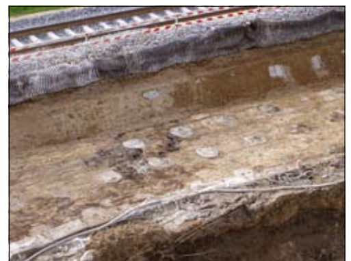
↑ Figuur 4 MIP kolommen voor de spoorlijn Hamburg - Berlijn
