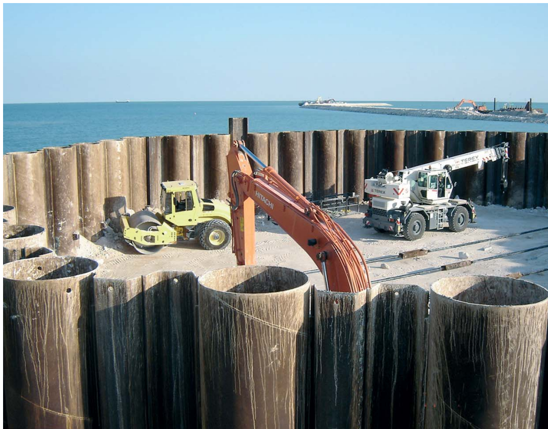
Figuur 6 Foto van de bouw van een kopconstructie.
