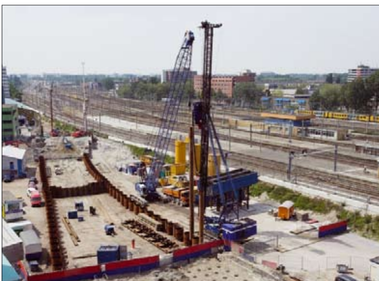
↑ Figuur 6 Locatie van de ontvangtschacht (op de achtergrond) met de zandophoging (foto: Aeroview)
