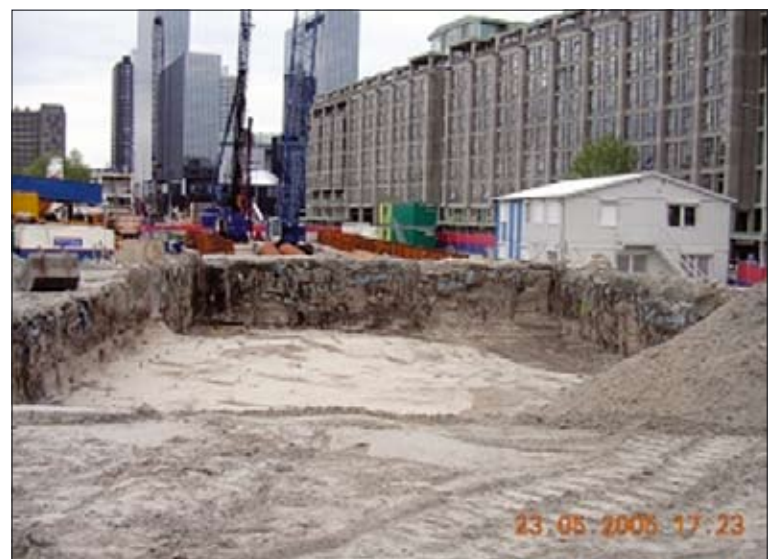
↑ Figuur 7 Locatie van de ontvangtschacht met de diepwanden en de verticale drains (foto: Aeroview)
