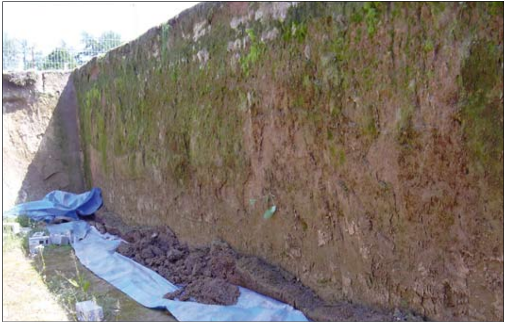
↑ Figuur 15 Staat van de afgeschermd wand na één jaar, na de verwijdering van de folie (juni 2006)
