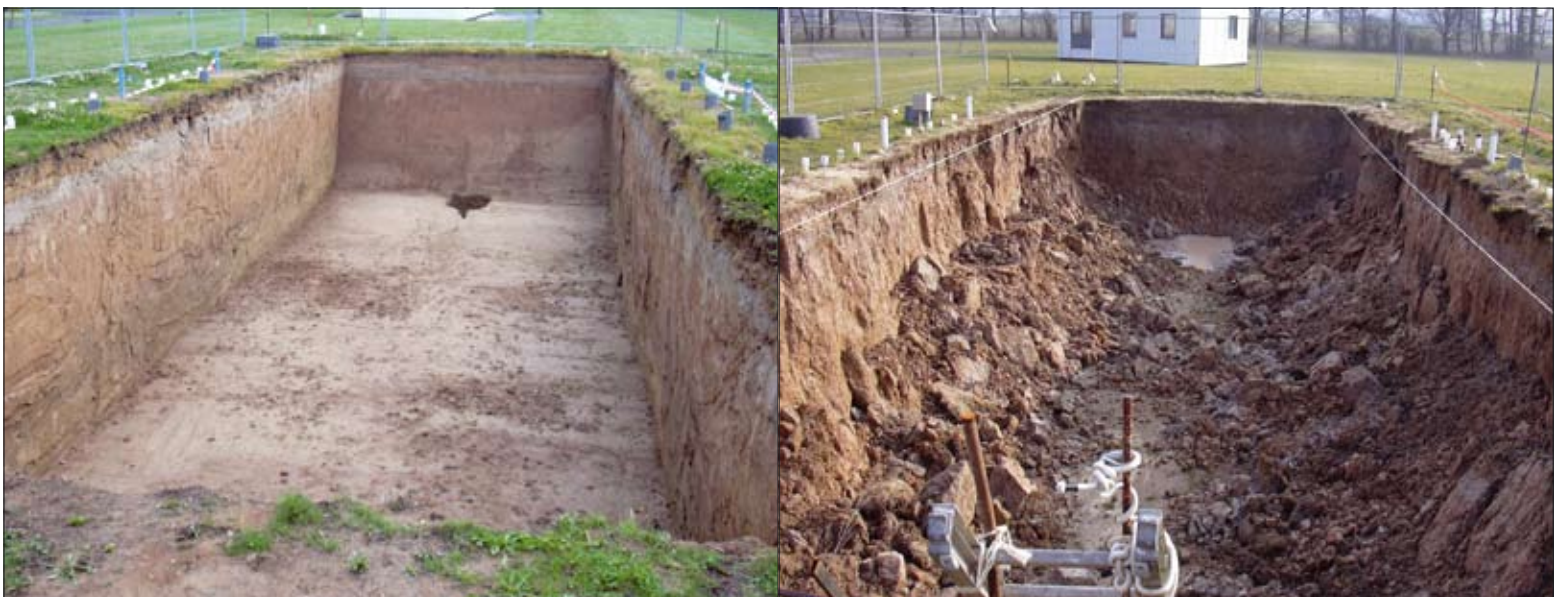
↑ Figuur 11 Eerste fase van de experimentele bouwput (afmetingen: 6 m breed, 20 m lang en 3 m diep)
