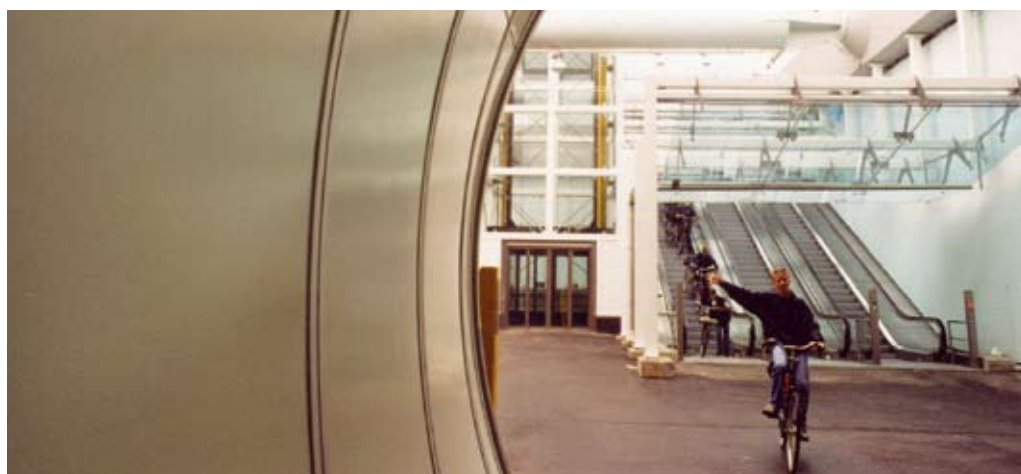
↑ Figuur 1 De entree tot de 2° Heinenoord tunnel
