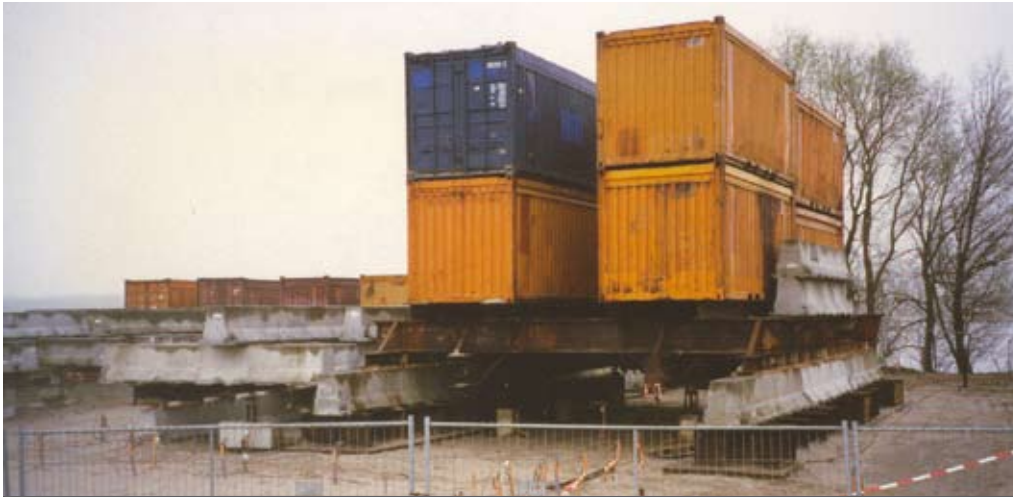
↑ Figuur 9 Proefopstelling voor de bepaling van de invloed van het tunnelboren op bestaande paalfunderingen
