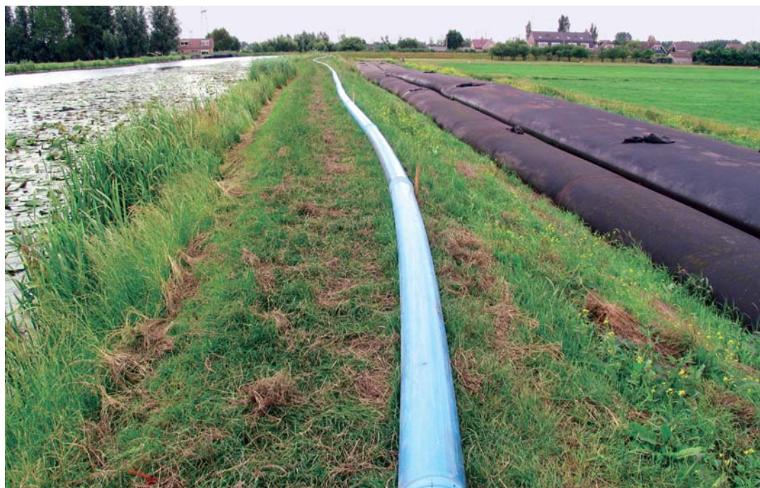
Figuur 2 Gevulde en ontwaterde geotextiele tubes t.b.v. de ontwatering van baggerspecie.
