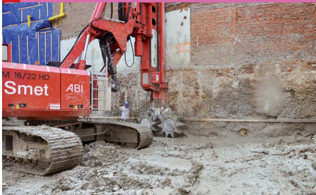
Figuur 3 Uitvoering CSM-wand op niveau -3.5m.
