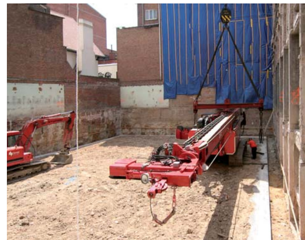
Figuur 2 Ook de boorstelling moet over de gevel.
