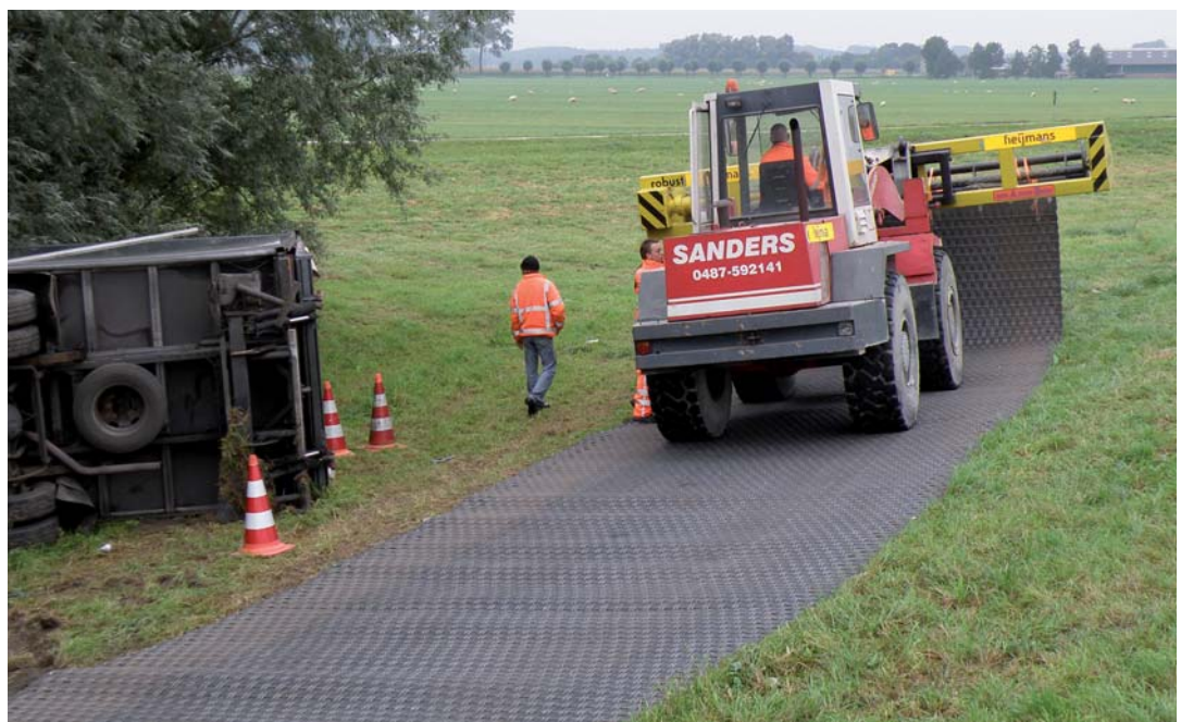
Figuur 4 Aanbrengen verplaatsbare wegdek Ewijk (links gekantelde vrachtauto).
