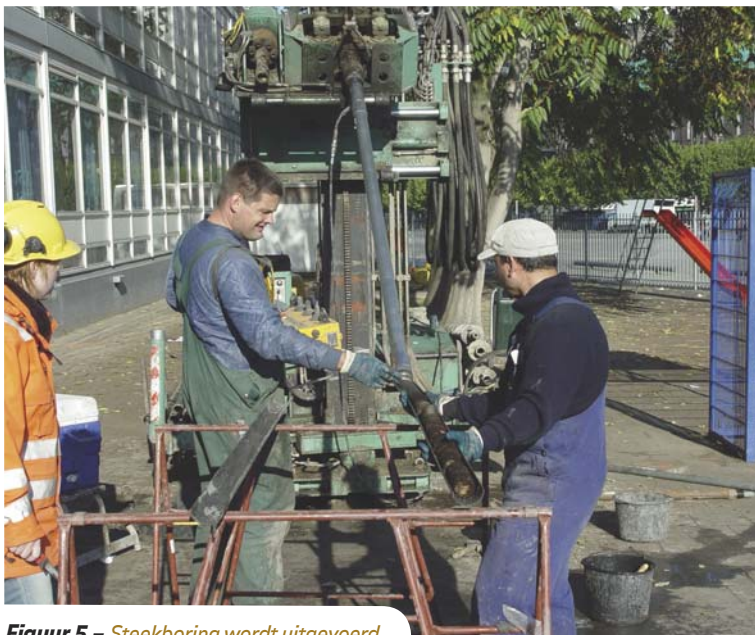
Figuur 5 – Steekboring wordt uitgevoerd.
