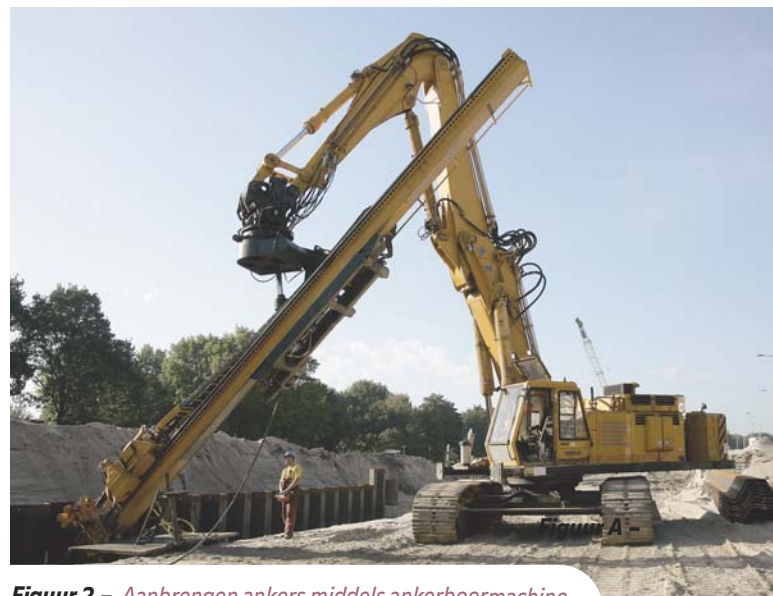
Figuur 2 – Aanbrengen ankers middels ankerboommachine.
