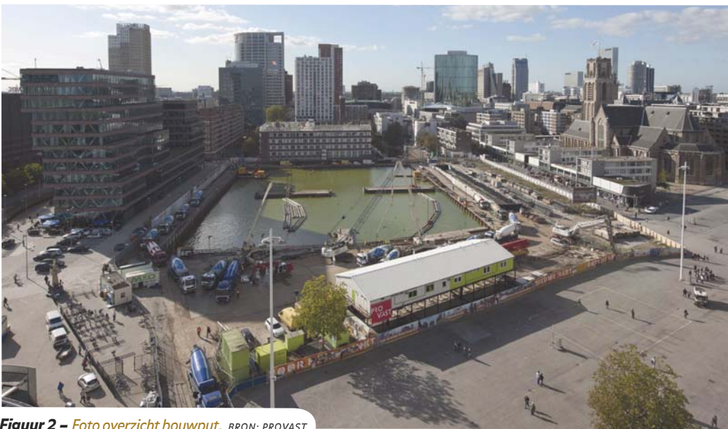
Figuur 2 – Foto overzicht bouwput. BRON: PROVAST
