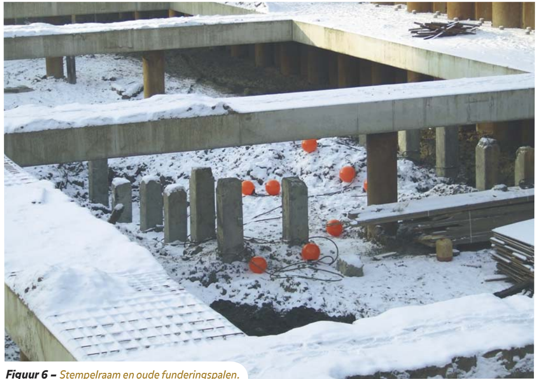
Figuur 6 – Stempelraam en oude funderingspalen.
