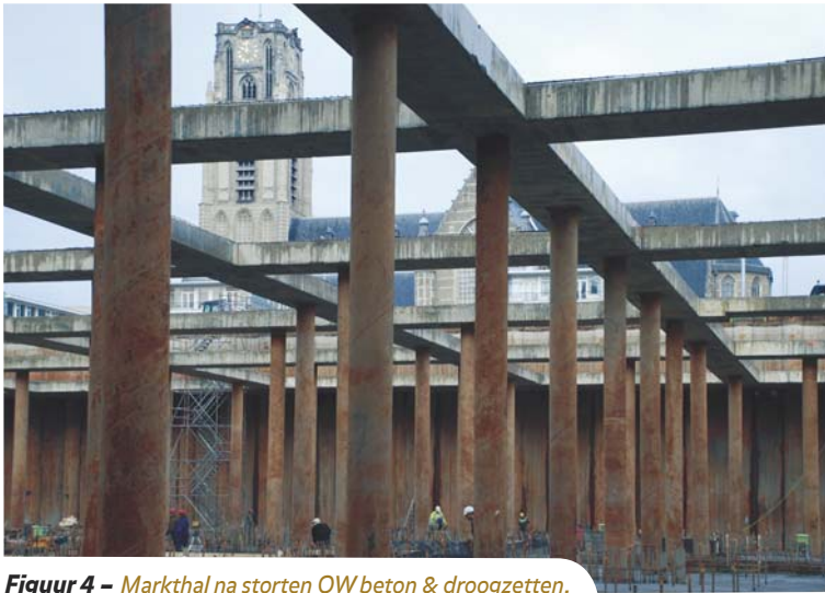
Figuur 4 – Markthal na storten OW beton & droogzetten.
