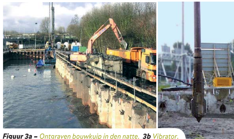
Figuur 3a – Ontgraven bouwkuip in den natte. 3b Vibrator.
