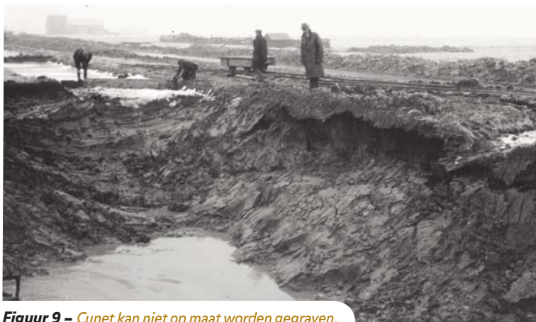
Figuur 9 – Cunet kan niet op maat worden gegraven.
