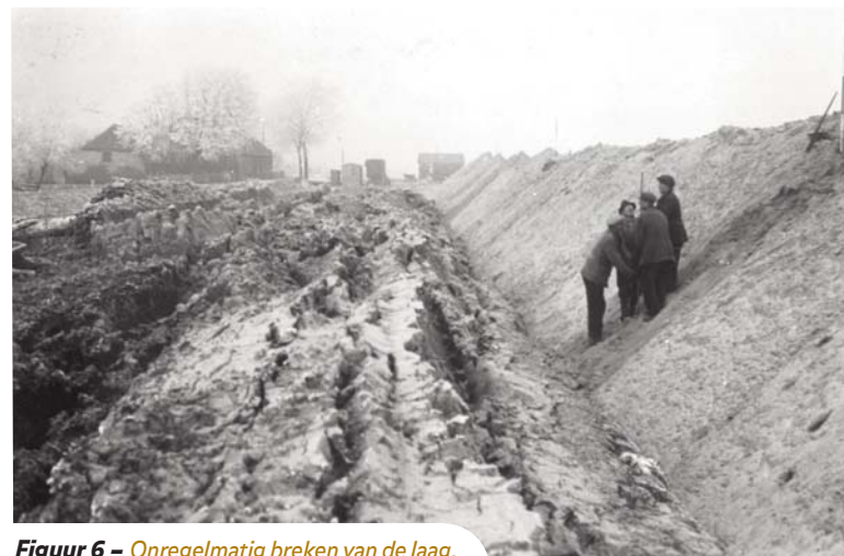
Figuur 6 – Onregelmatig breken van de laag.
