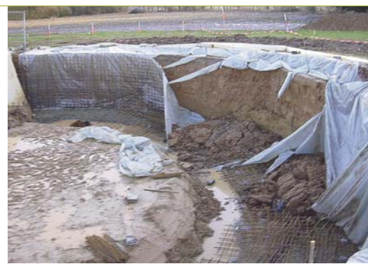
Figuur 1 – Links: voorbeeld van een bouwput waarvan de stabiliteit niet verklaard kan worden met de traditioneel aanbevolen rekenmethoden en grondparameters. Boven: bruuske en onverwachte instorting van een bouwput.
