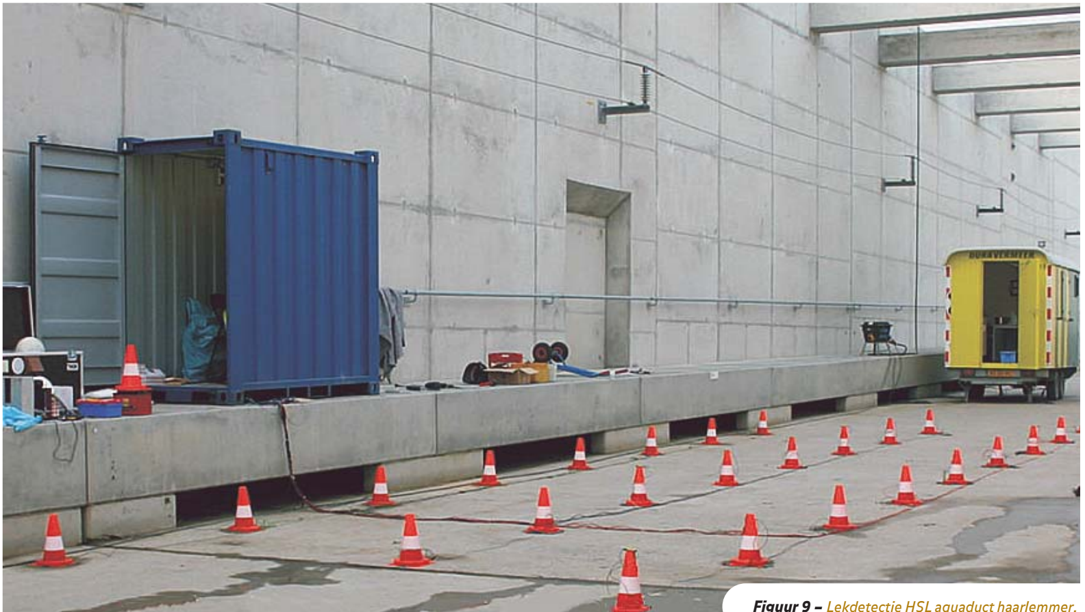
Figuur 9 – Lekdetectie HSL aquaduct haarlemmer.
