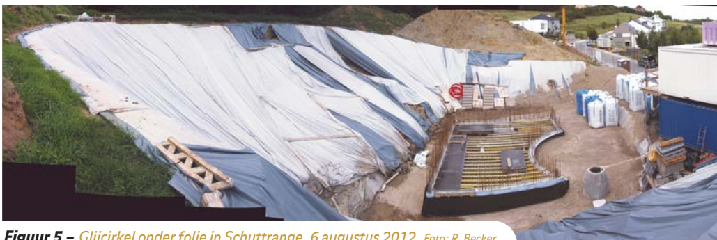
Figuur 5 – Glijcirkel onder folie in Schuttrange, 6 augustus 2012. Foto: R. Becker
