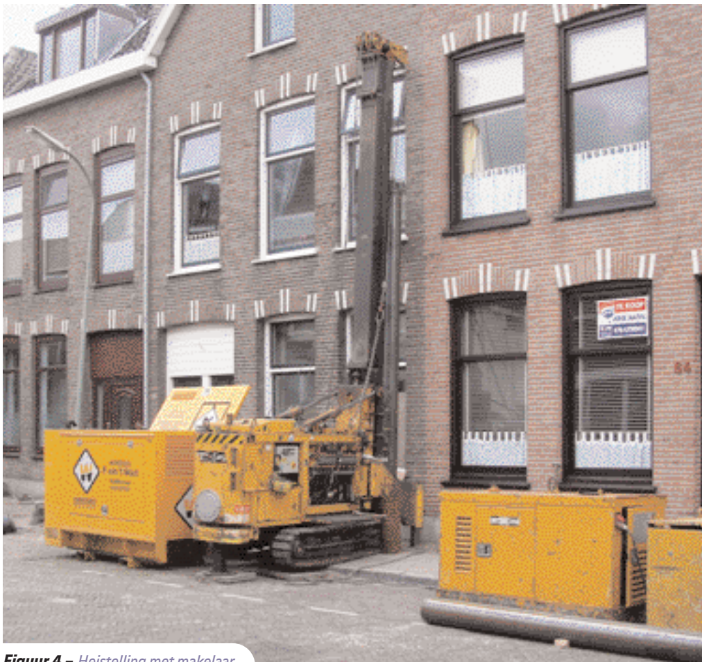
Figuur 4 – Heistelling met makelaar.
