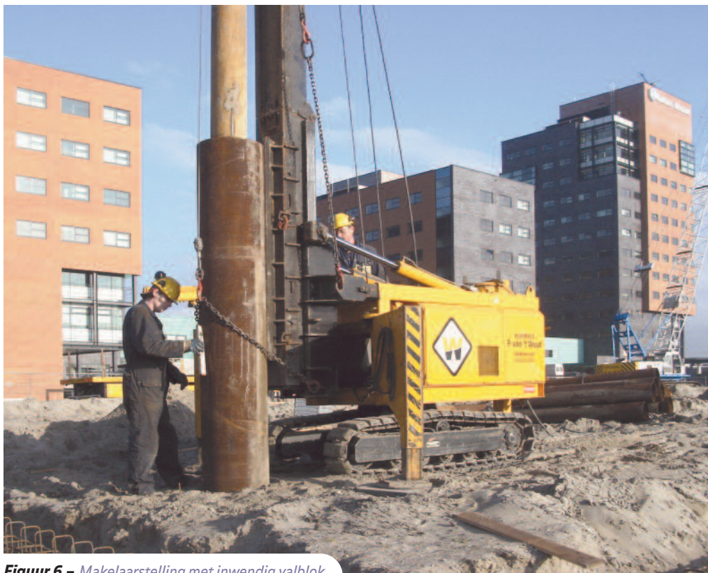
Figuur 6 – Makelaarstelling met inwendig valblok.
