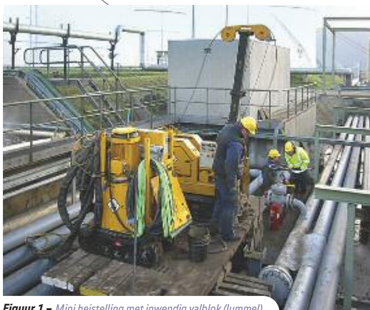
Figuur 1 - Mini heistelling met inwendig valblok (lummel).
