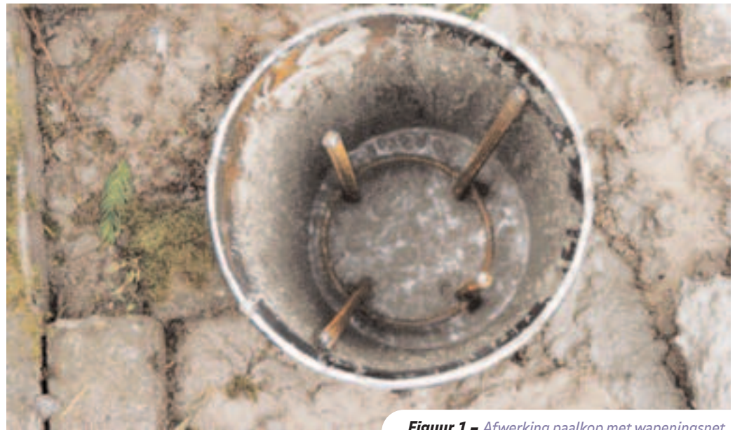
Figuur 1 - Afwerking paalkop met wapeningsnet.
