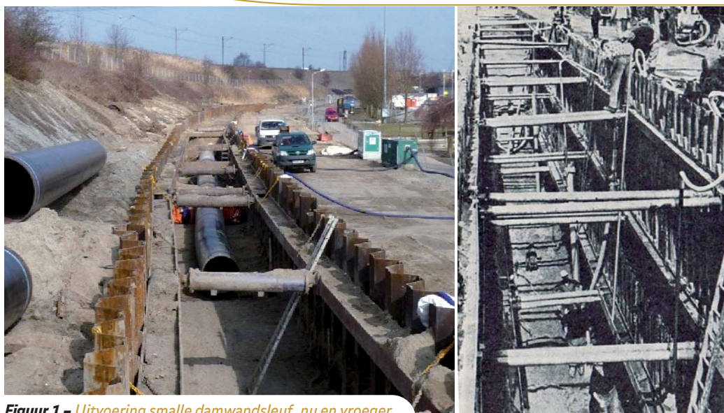
Figuur 1 – Uitvoering smalle damwandsleuf, nu en vroeger.
