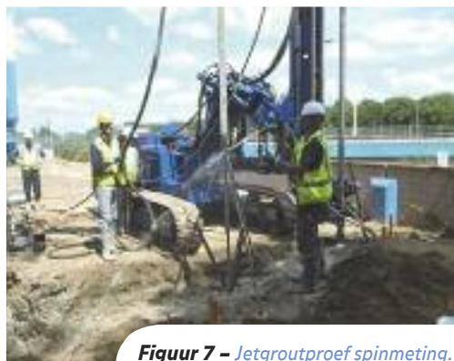
Figuur 7 – Jetgroutproef spinmeting.
