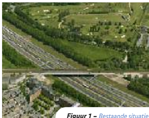
Figuur 1 – Bestaande situatie.
