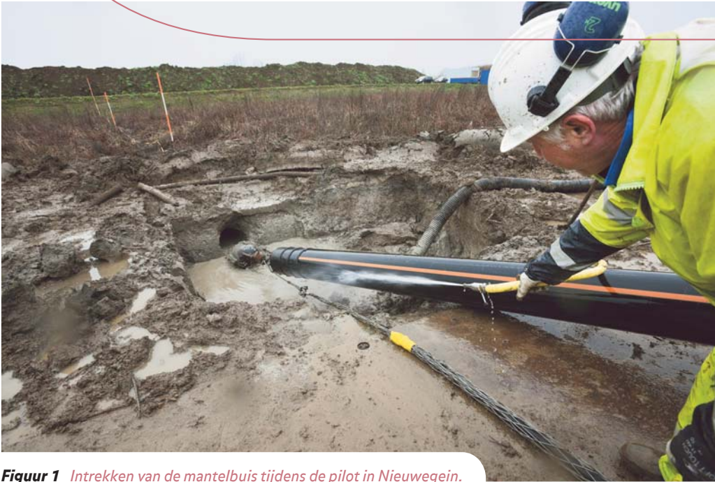
Figuur 1 Intrekken van de mantelbuis tijdens de pilot in Nieuwegein.
