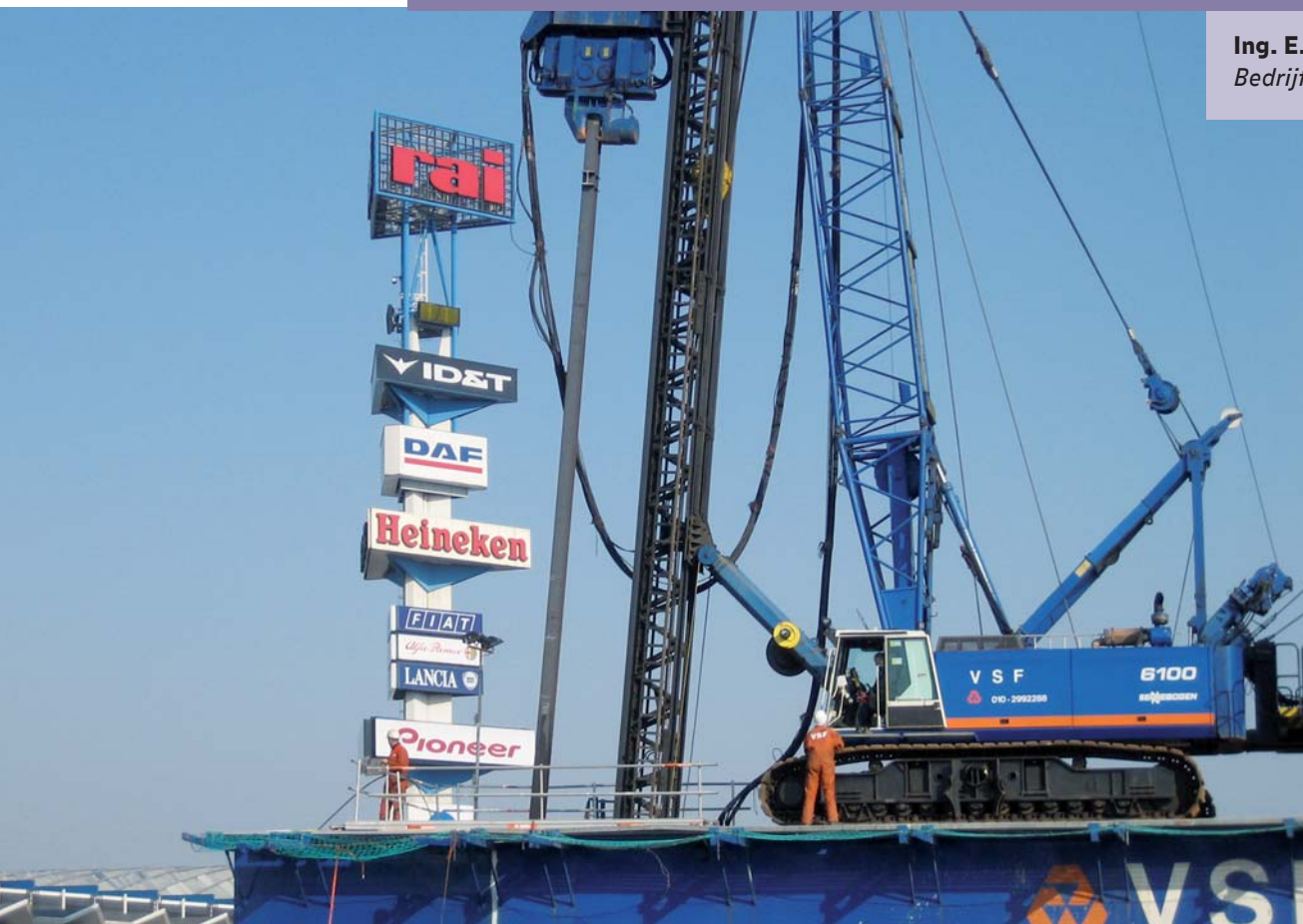
Figuur 1 Aanbrengen palen vanaf traverse.
