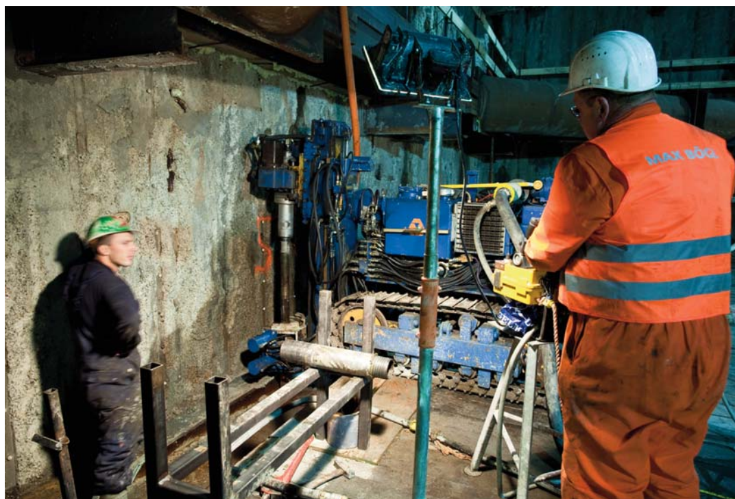
Figuur 2 Boren van de vrieslansen onder de gording.
