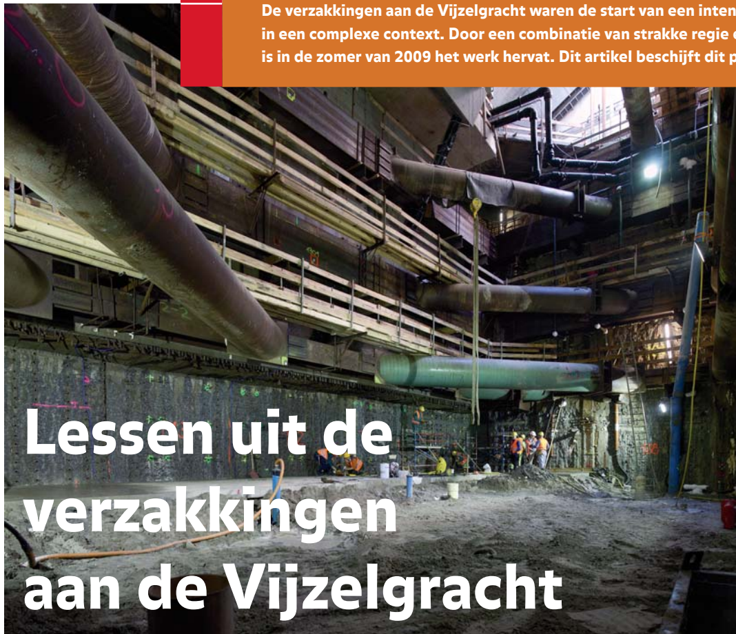
Figuur 1 Vijzelgracht ontgraven tot op NAP -22m. Nog 10m te gaan.
