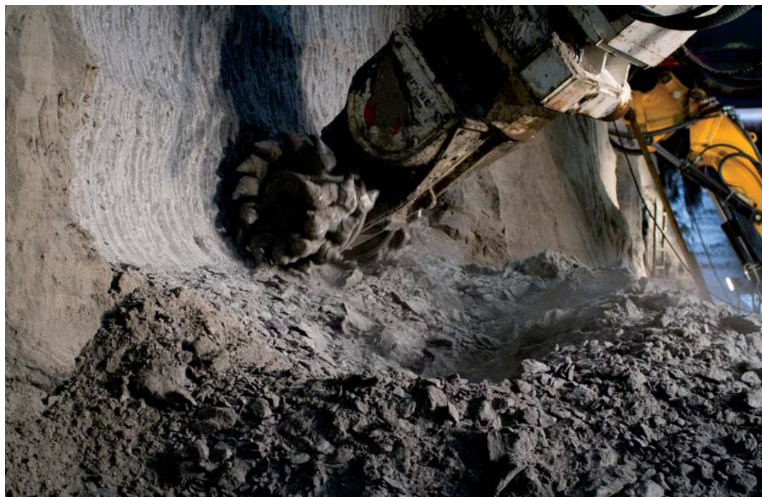
Figuur 3 Frezen van de bevroren grond.
