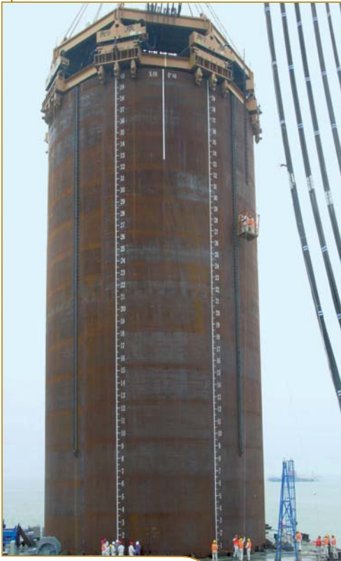
Figuur 1 – Intrillen buispaal (22 m diameter) met Octakong.
