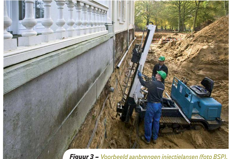
Figuur 3 – Voorbeeld aanbrengen injectielansen (foto BSP).
