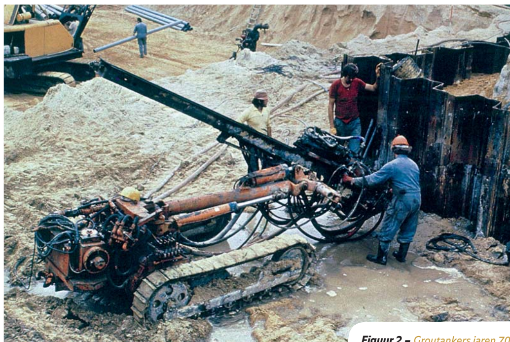
Figuur 2 – Groutankers jaren 70.
