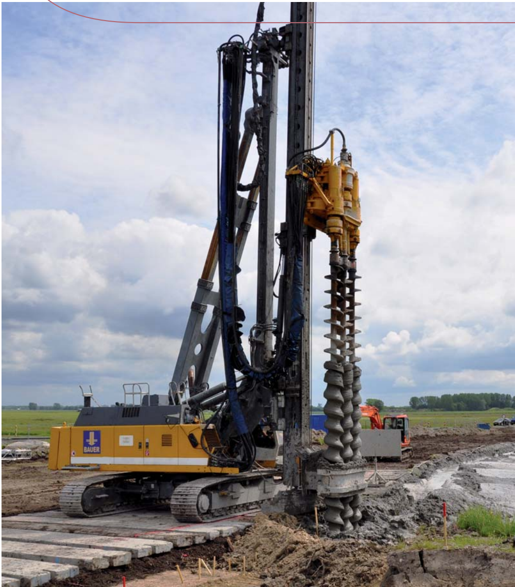
Figuur 1 - Draairichting 3-voudige avegaren.
