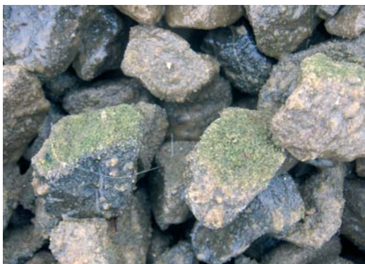
Figuur 2 Elastocoast dijkbekleding met aangroei van Klein Darmwier.
