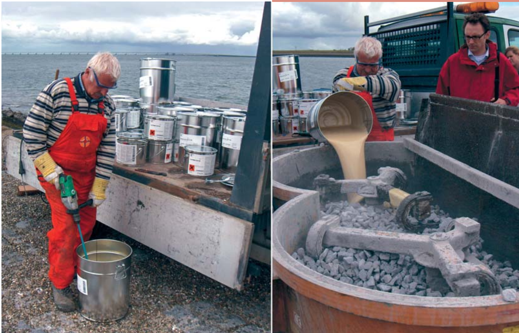
Figuur 1 De twee Elastocoast componenten die samen het polyurethaan vormen worden eerst met elkaar gemengd (l), en dat mengsel wordt vervolgens met de kalksteen (20/40) gemengd (r).
