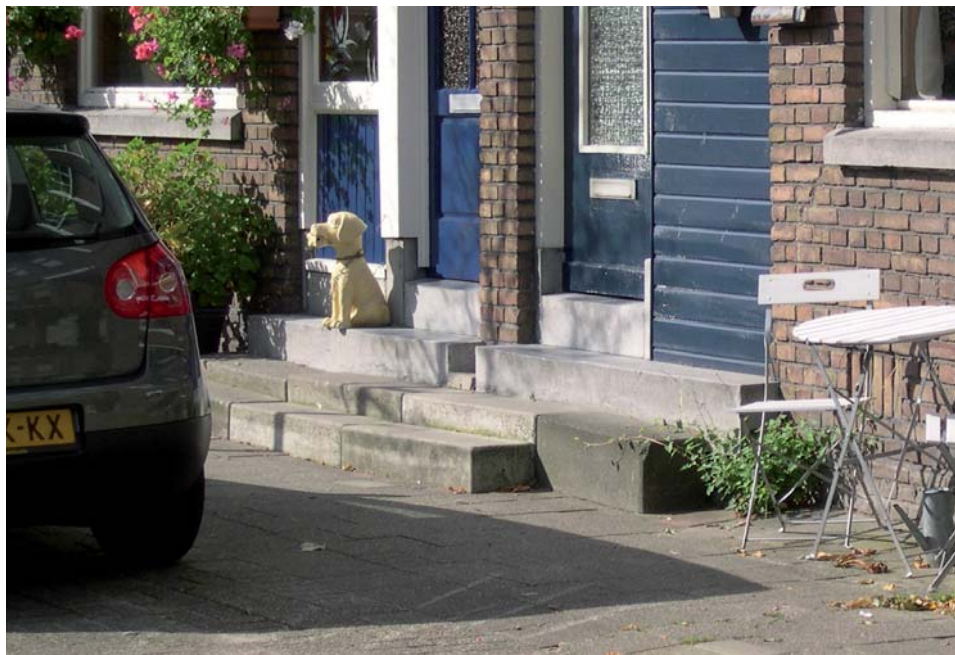
Figuur 2 Dit opstapje wordt met de jaren steeds groter op een slappe bodem.
