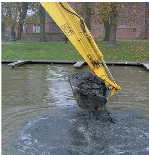
Figuur 2 Baggeren in uitvoering.
