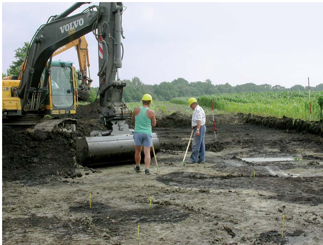
Figuur 1 Afzet van grond en bagger bij natuurbouwproject.
