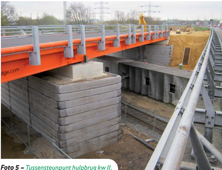
Foto 5 – Tussensteunpunt hulpbrug kw II.
