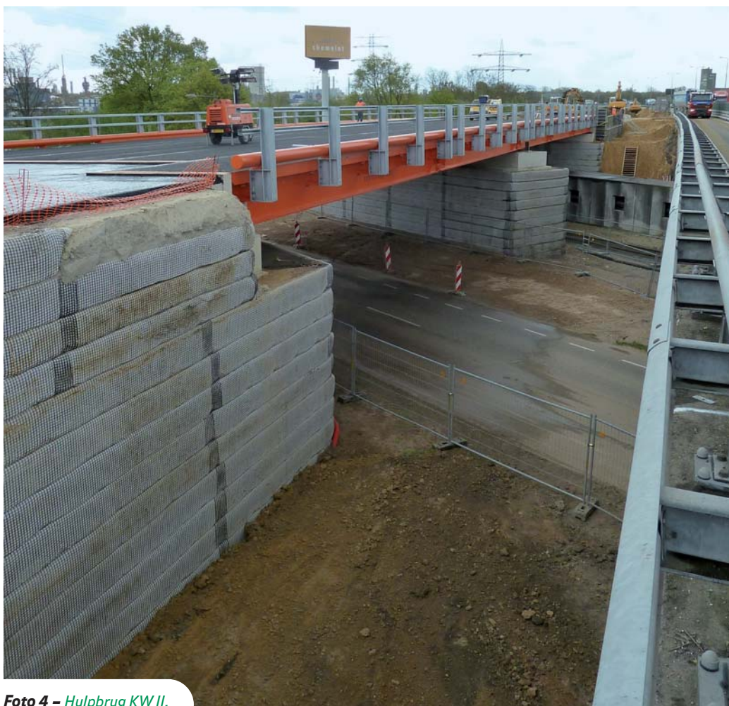
Foto 4 – Hulpbrug KW II.
