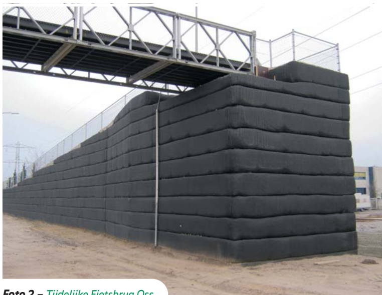
Foto 2 – Tijdelijke Fietsbrug Oss.
