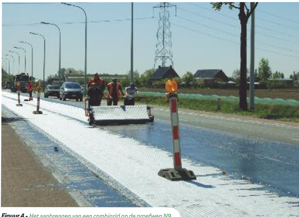
Figuur 4 - Het aanbrengen van een combigrid op de proefweg N9.
