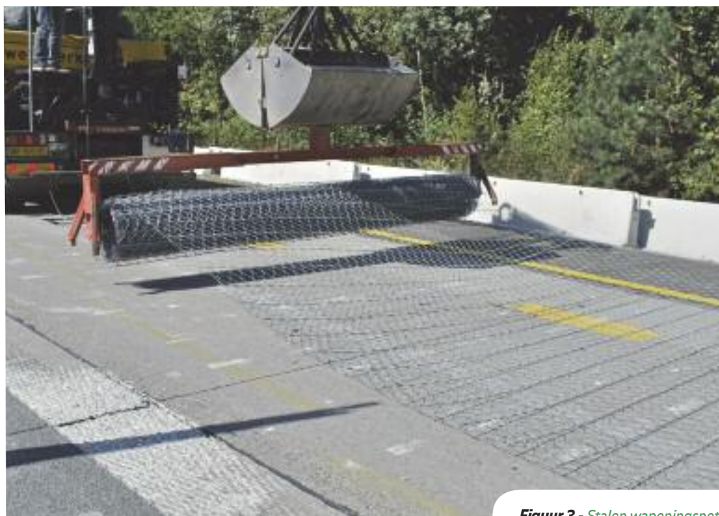
Figuur 3 - Stalen wapeningsnet.
