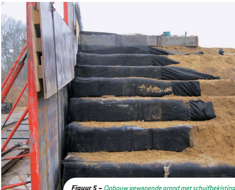
Figuur 5 – Opbouw gewapende grond met schuifbekisting.
