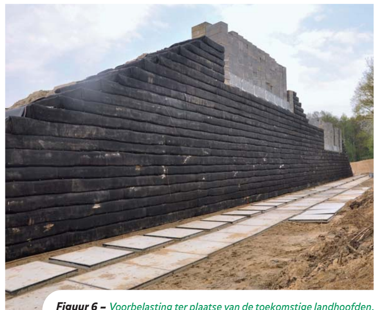
Figuur 6 – Voorbelasting ter plaatse van de toekomstige landhoofden.
