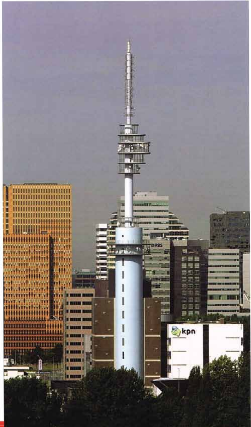
Telecommunicatietoren in de Zuidas Amsterdam.
